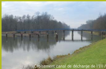
Croisement canal de décharge de l'III / canal du Rhône au Rhin à Krafft.
